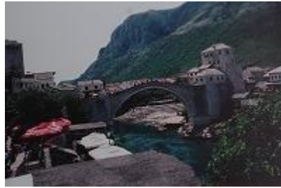
爆撃後復旧した石橋
