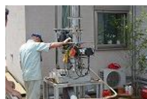
敷地内に井戸を掘る
