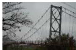
揖保川の吊り橋
