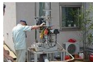
敷地内に井戸を掘る
